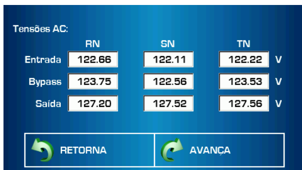
Tela de medições das tensões de entrada, bypass e saída do No-break
