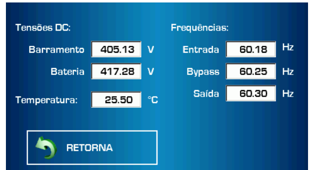
Tela de medições de frequências de entrada, bypass e saída e também as tensões DC barramento e bateria
